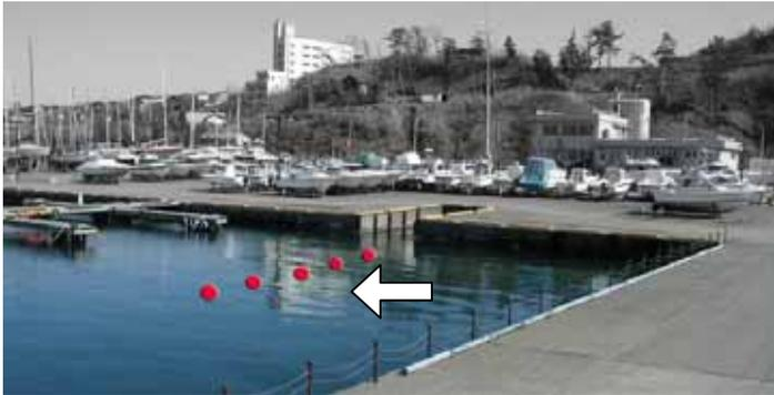
係留方法は小型栈橋への係留と同様、船首を岸壁側に向けて前後をロープとブイで固定するようになっています。
