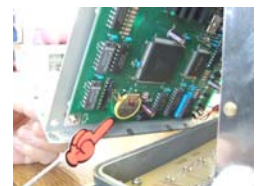
電池は振動で外れないように基盤にしっかりと固定されています。
