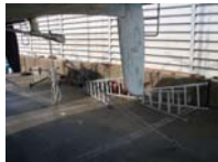
駐車場の隅には多くの脚立が放置されています。
